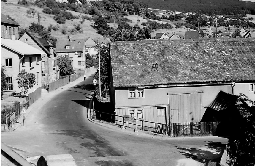
Abbildung 21: Das alte Wagner-Haus im Jahre 1958. Es ist vom Aufbau quasi identisch mit dem Plan von 1873. Rechts vorne, der kleine Anbau, ist ein Schweinestall. Links vom Haus stand noch eine große Scheuer, die aber abgerissen wurde, weil sie der Brunhildenstraße weichen musste. [J. Berbott via S. Eckermann]
